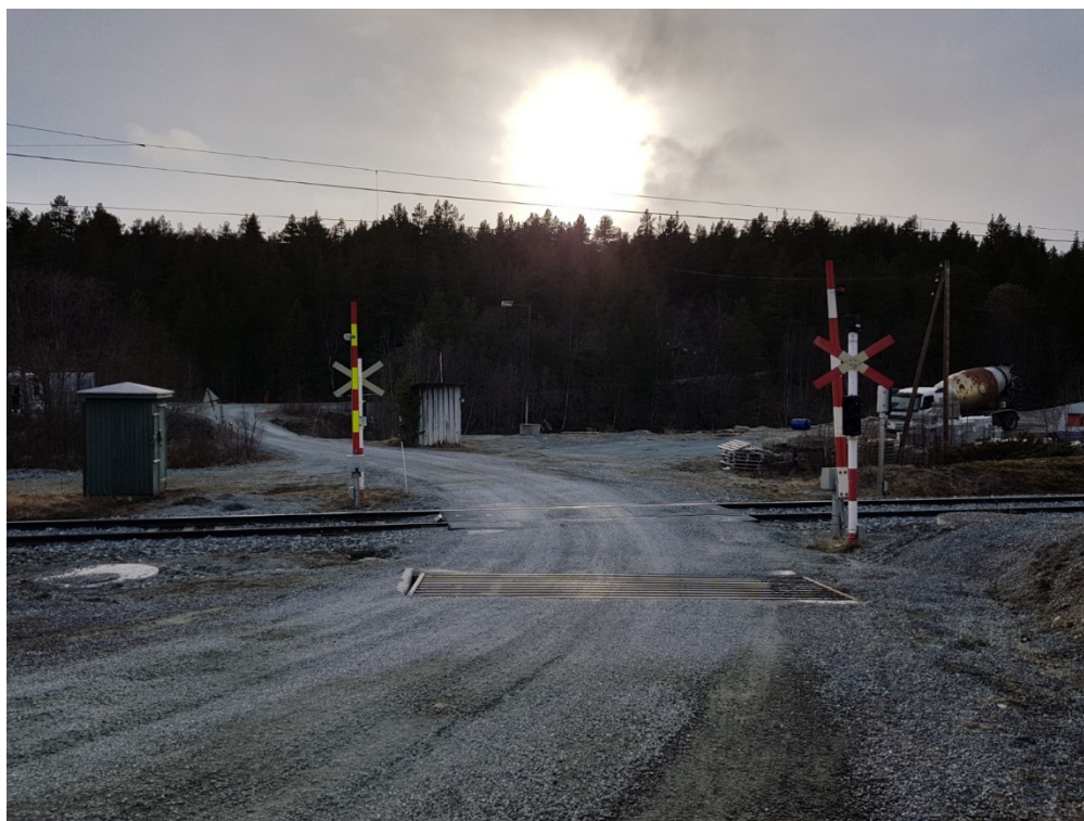
Fig. 24: viser regulert planovergang-jernbane.
