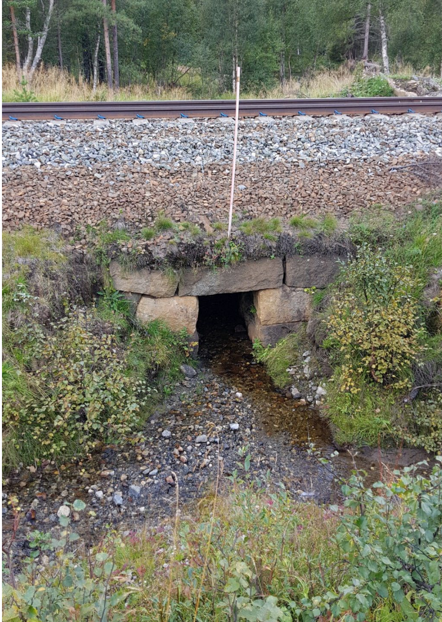
Fig. 29: Viser stikkrenne under jernbanelinje.
