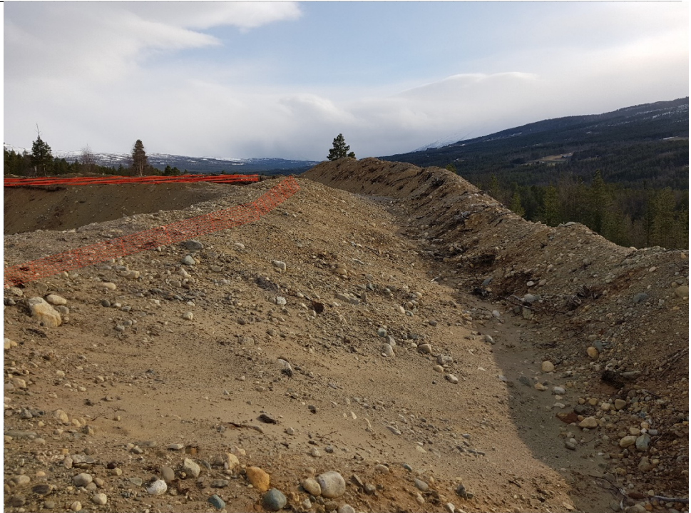
Fig. 34: Viser sperregjerder i avdekningsområdene
