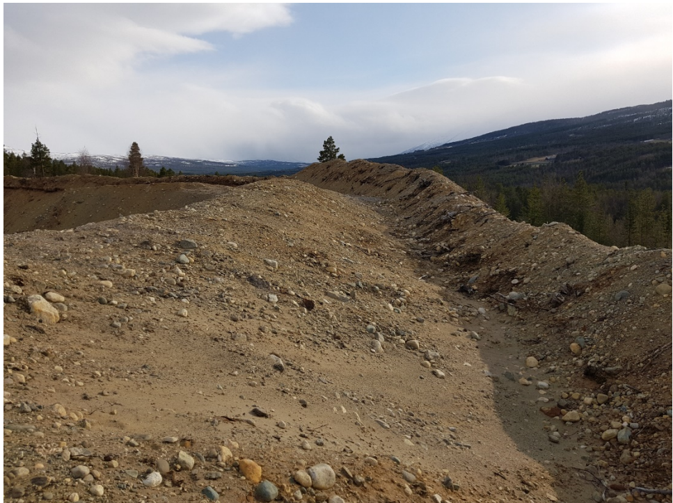
Fig. 32: Uttaksskråning med toppmasse lagt opp som jordvoll mot nordvest.
