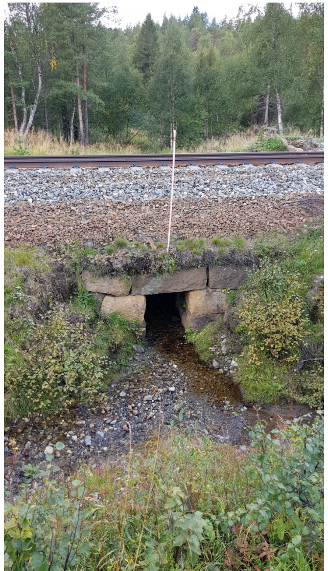
Fig. 10: Viser stikkrenne under jernbanelinje nedstrøms masseuttaket.
