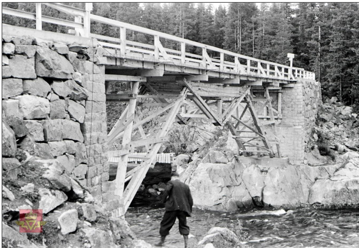
Kløftbrua 1940 (kilde: SVV)
