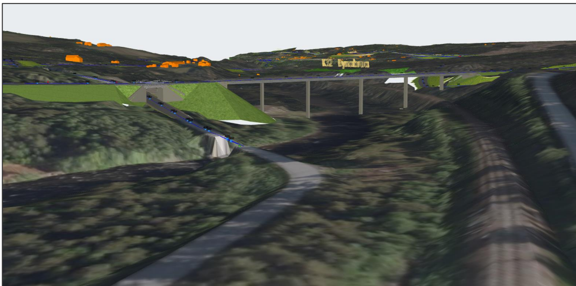
Figur 50: Bru over Bynas elvedal ved Nedgård sett mot nord. Seierdalsveien er lagt i kulvert gjennom fyllingen ved vestre landkar.
