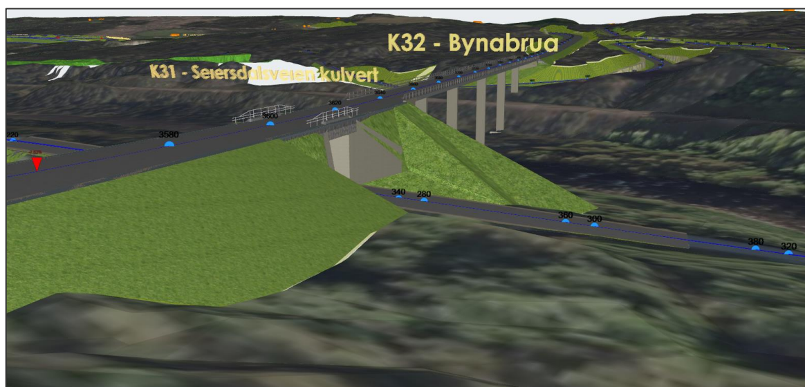
Figur 51: Bynabrua, veifyllingen og kulverten for Seiersdalsvegen sett mot øst.
