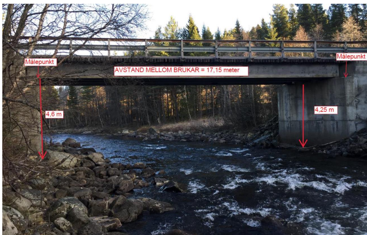
Figur 5-18. Innmålinger på eksisterende kjørebru. Bildet tatt nedstrøms brua.
