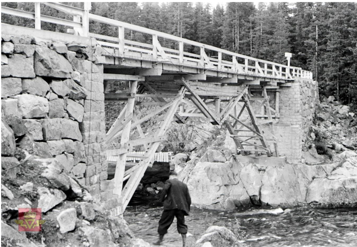
Kløftbrua 1940 (kilde: SVV)
