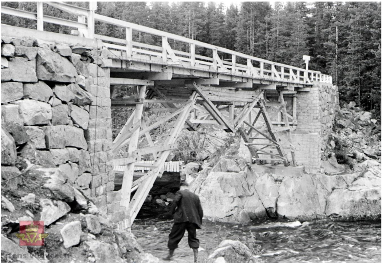
Kløftbrua 1940 (kilde: SVV)
